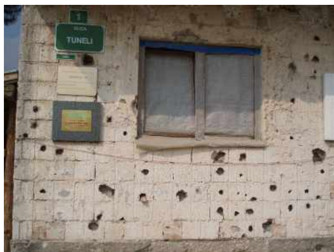
Fra dette huset begynte de å grave ut tunnelen.
